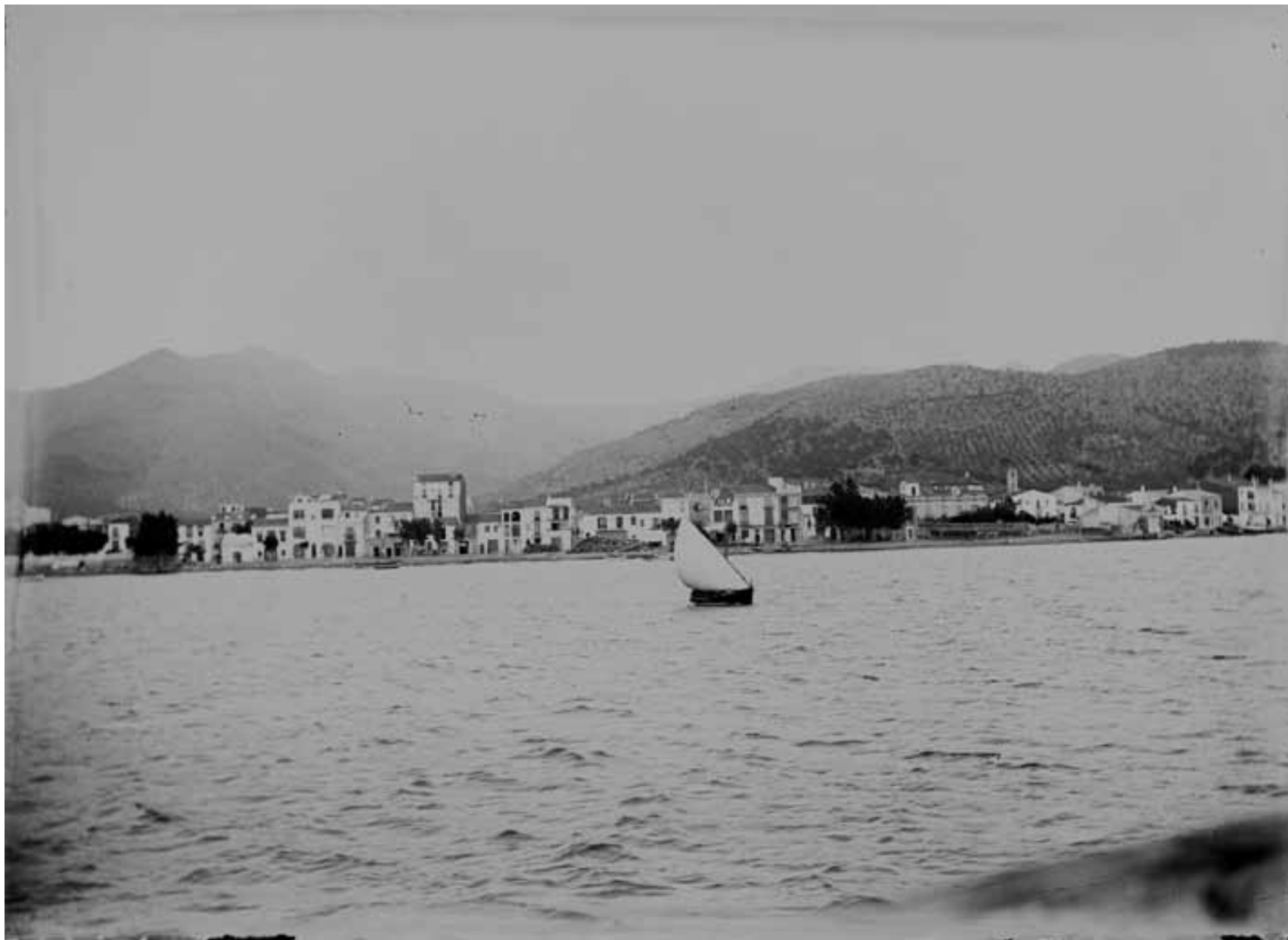
Façana marítima de Roses - 2a década s.XX
