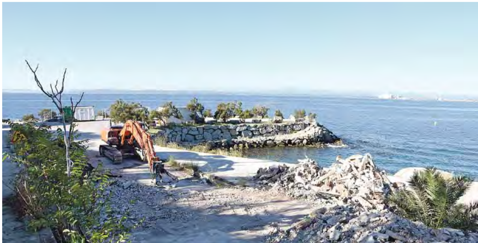
RETIRADA DE RUNA. La maquinària de Costes treballa des de finals de setembre a l'espai de l'antiga depuradora
