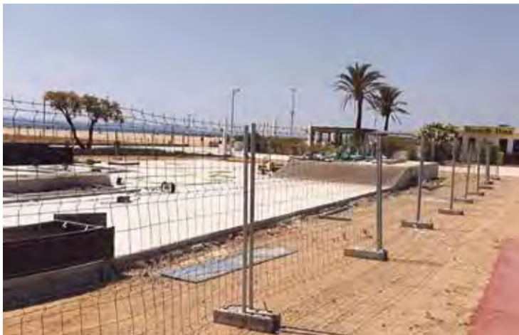
OBRES. Les construccions es troben en la recta final
