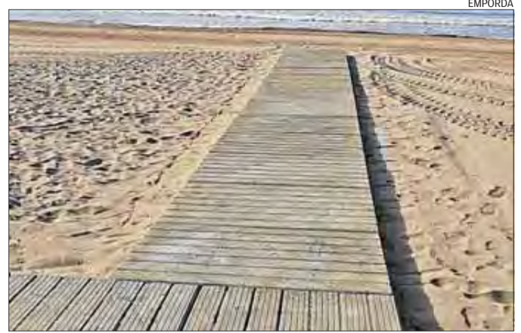
Així és l'aspecte que té el pas de formigó que millora l'accessibilitat.
