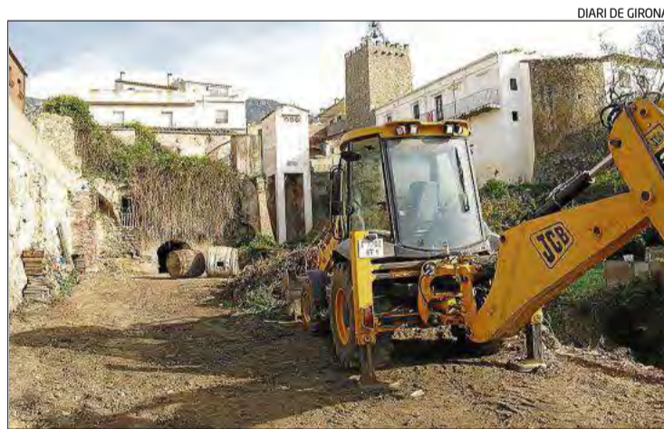
Les màquines treballant en l'enderroc de can Lluent.
