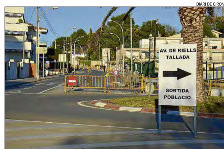
A la zona afectada s'hi ha instal·lat senyalització alertant dels canvis.
