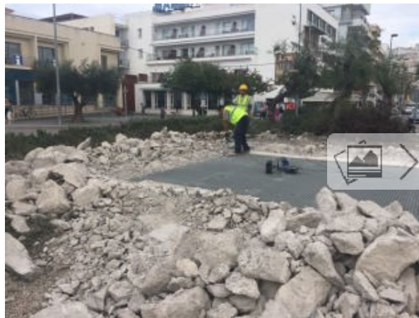
Les obres que es fan a la rotonda. AJUNTAMENT DE ROSES
