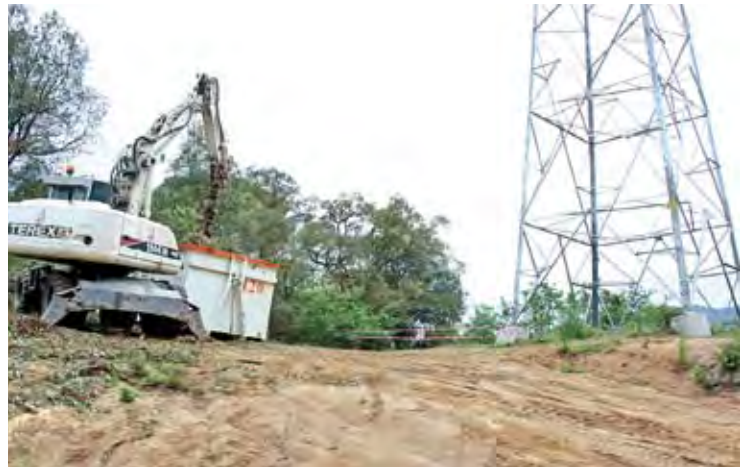
OBRES. Treballs per aixecar les torres elèctriques
