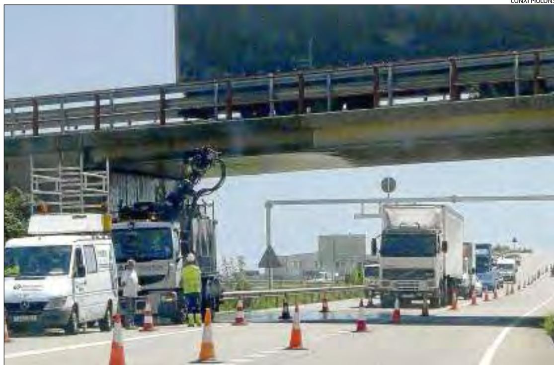
Els operaris reparant els danys a la part baixa de l'estructura i l'estructura metàl·lica darrere el pont.
