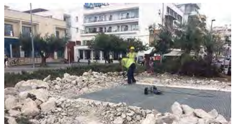
D'AVANT DE L'OFICINA DE TURISME. Retirada del muret de contenció al giratori
