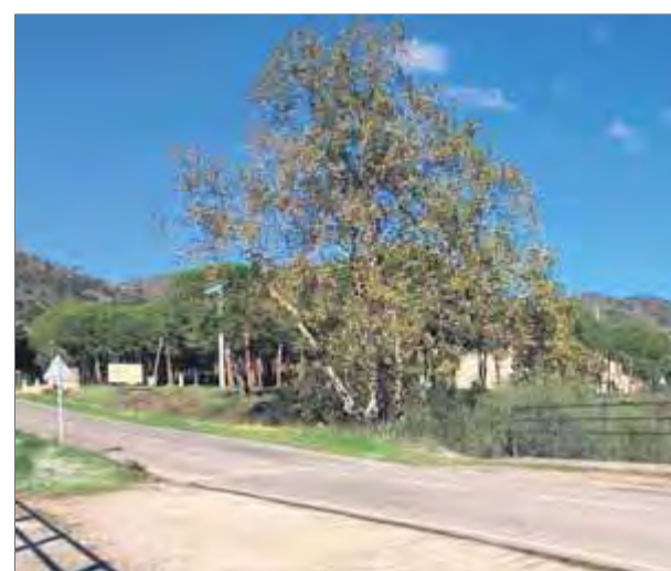
El pont sobre la riera Trencada de la carretera de les Arenes necessita una reparació ■ JOAN PUNTÍ
