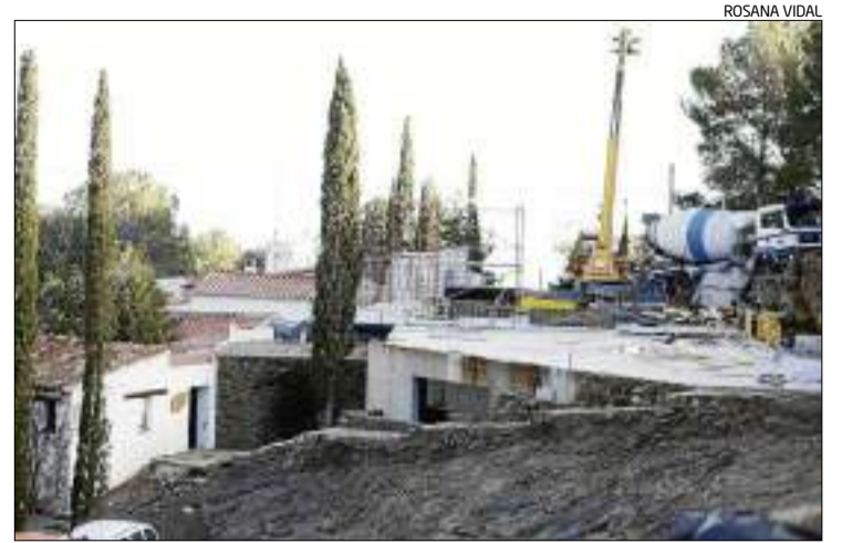
Les màquines, treballant en l'ampliació del Bulli.
