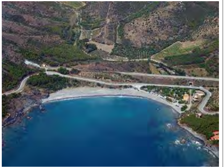
ESTIU. La cessió dels terrenys acabarà el 15 de setembre d'aquest any
