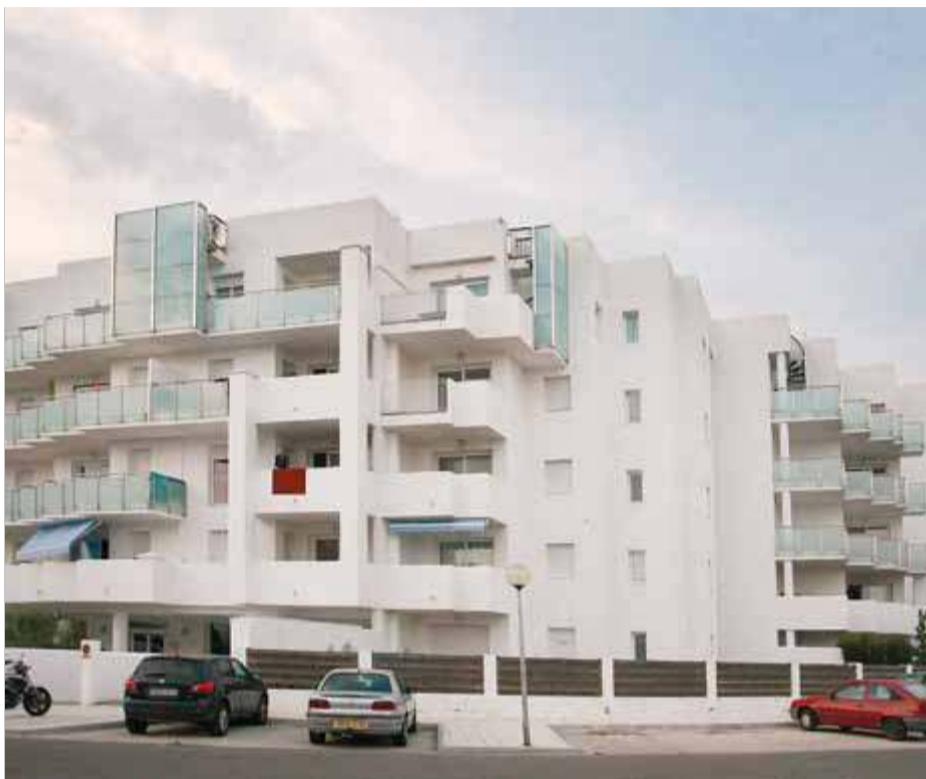
En la sentència del TSJC s'ordena l'enderroc de l'última planta del Royal Marine II arran de la denúncia d'uns veïns perquè l'edifici és massa alt ■ LLUÍS SERRAT
