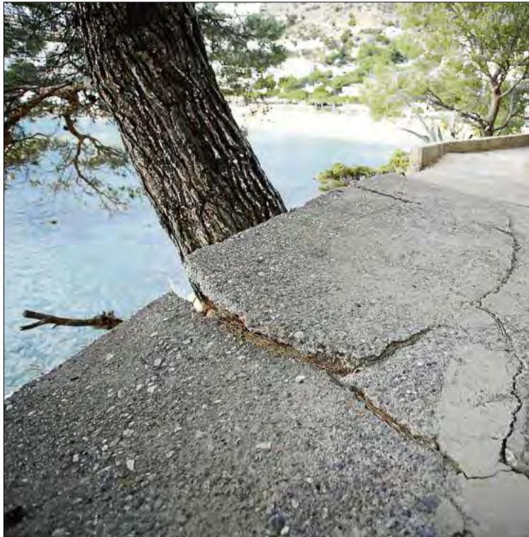
El ferm en mal estat en un punt sense protecció al penya-segat. Els tubs de les canalitzacions al descobert en el recorregut de Canyelles a l'Almadrava.
