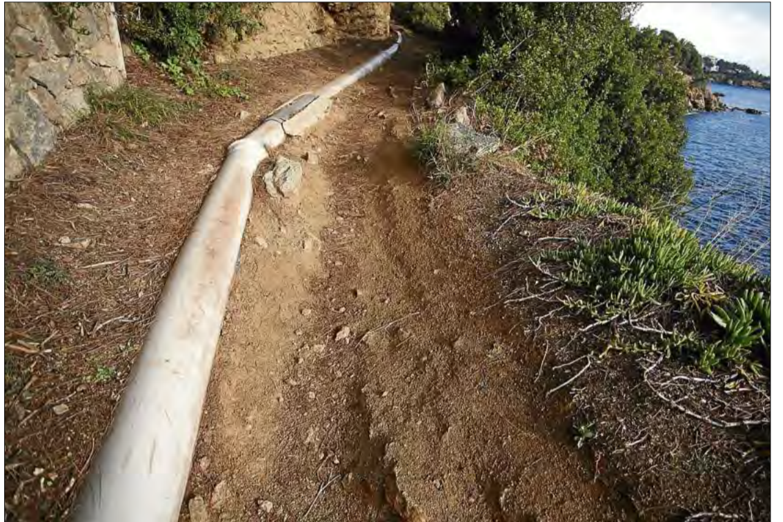
El ferm en mal estat en un punt sense protecció al penya-segat. Els tubs de les canalitzacions al descobert en el recorregut de Canyelles a l'Almadrava.
