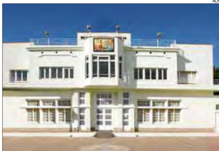
L'edifici es va reformar fa quatre anys i ara té un nou espai escènic.
