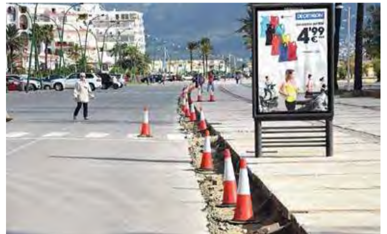
ASFALTATGE I CARRIL BICI. A tota la vorera i a l'entorn dels edificis
