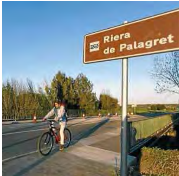
Una de les obres subvencionades el 2014 és la millora del pont sobre la riera de Palagret a Celrà ■ EDDY KELELE
