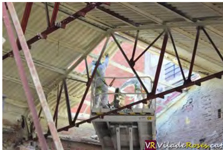
Operaris enretirant la uralita de la teulada de la sala SUF de Roses
