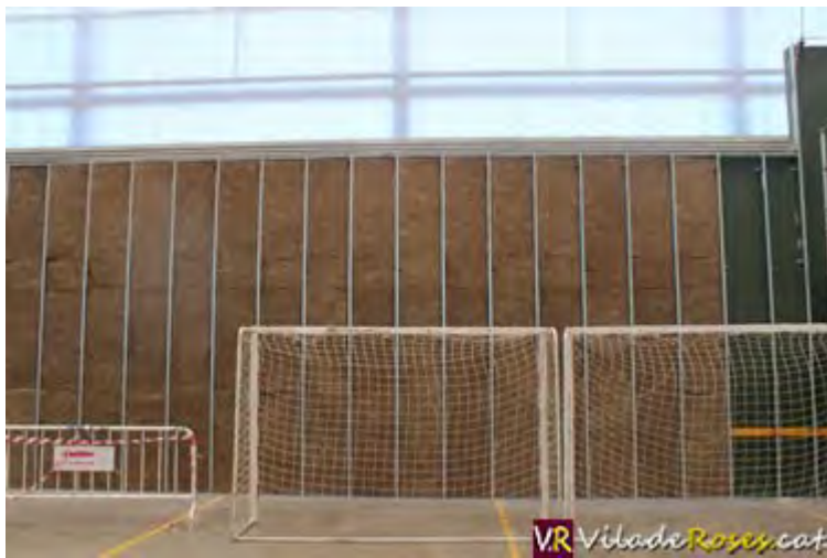
Revestiment a les parets de la sala annexa per millorar la seva sonorització
