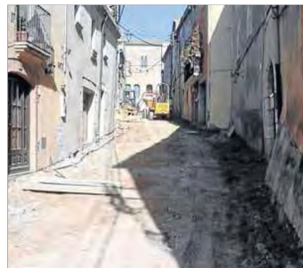
Arran de les obres, que s'allargaran unes tretze setmanes, el carrer Major es tallarà al trànsit ■ J.T.
