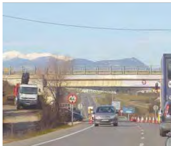
Obres a la C-66, al tram conegut com a variant de Banyoles, el 2012 ■ RAMON ESTEBAN
