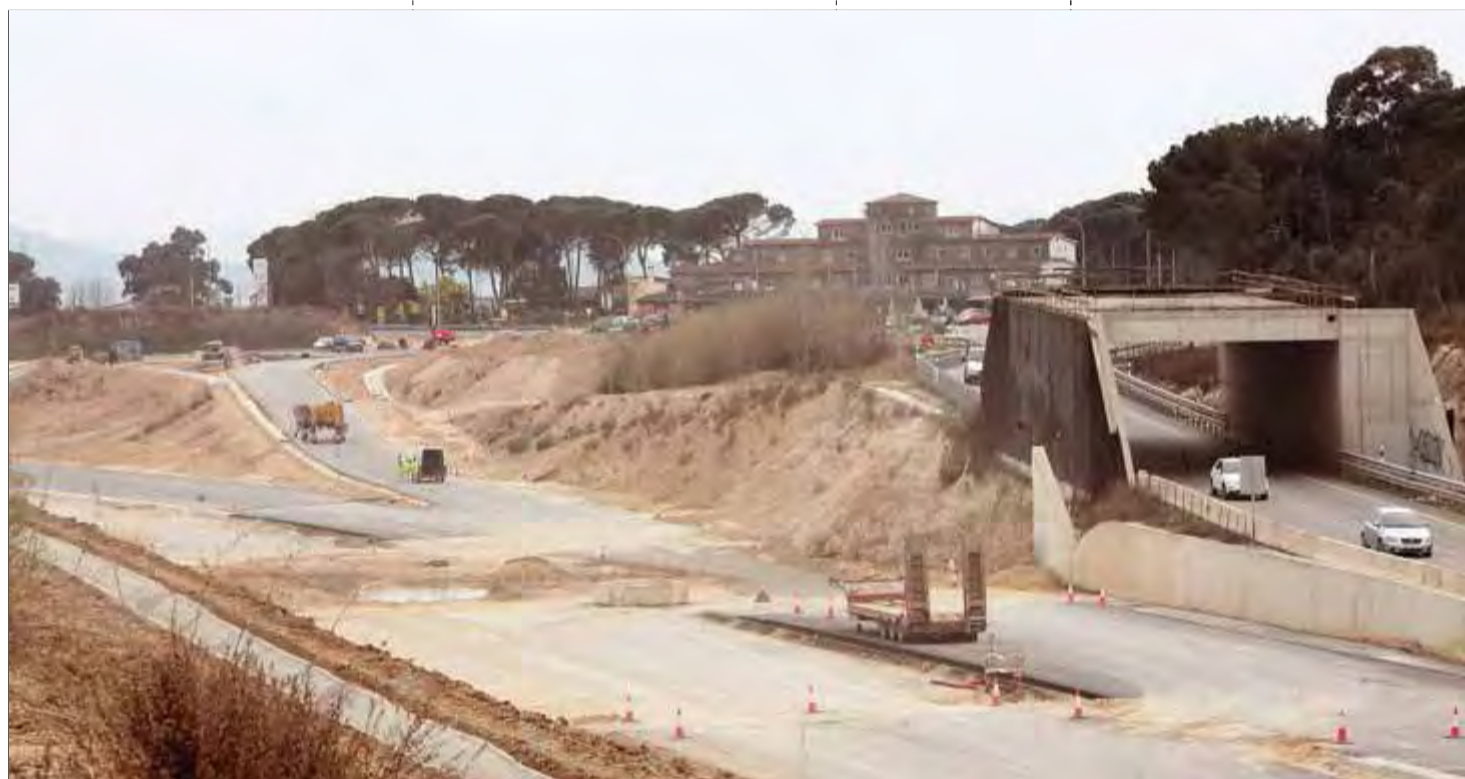
Les obres de l'N-II davant l'entrada a Caldes de Malavella. Al fons, el restaurant La Llotja ■ JOAN SABATER
