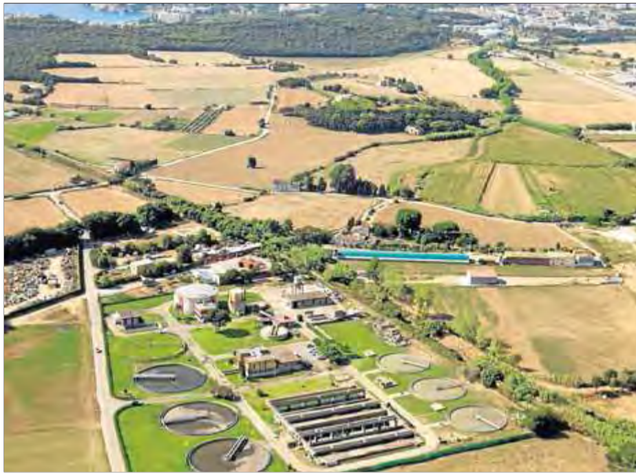
Panoràmica de l'estació depuradora de Palamós, en una imatge d'arxiu. També remodelaran la de Tossa i les estacions de bombament de Sant Feliu de Guíxols i Roses ■ EL PUNT AVUI
