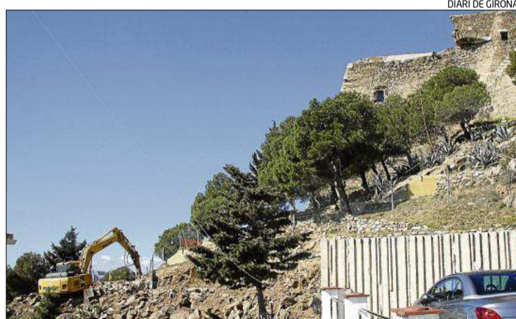
Les obres de construcció de l'aparcament.
