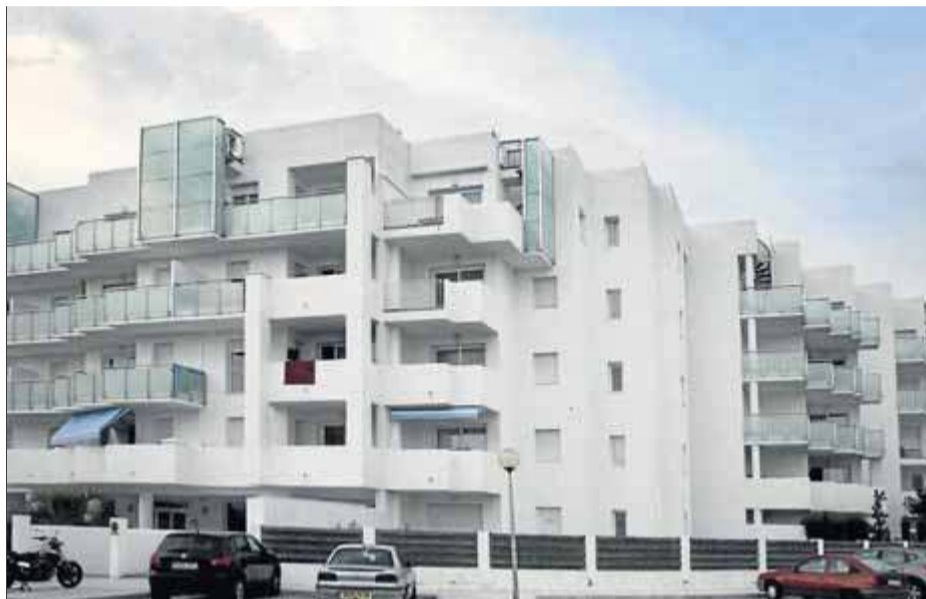
La indemnització de 2,2 milions evitarà haver d'escapçar l'edifici del Royal Marine II ■ EPA
