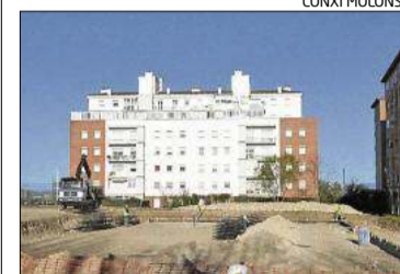
Les màquines, treballant a la zona.
