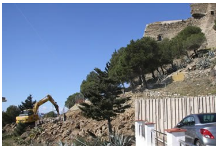
S'han iniciat els treballs de creació d'un nou aparcament del Castell de la Trinitat de Roses
