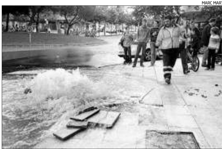
El punt d'origen de la fuga, amb la vorera aixecada per l'aigua.
