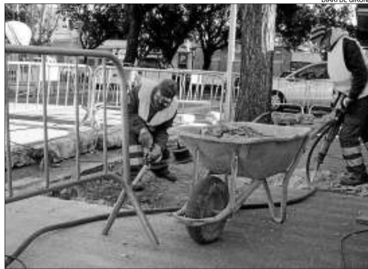
Operaris de la brigada municipal fent tasques de manteniment.
