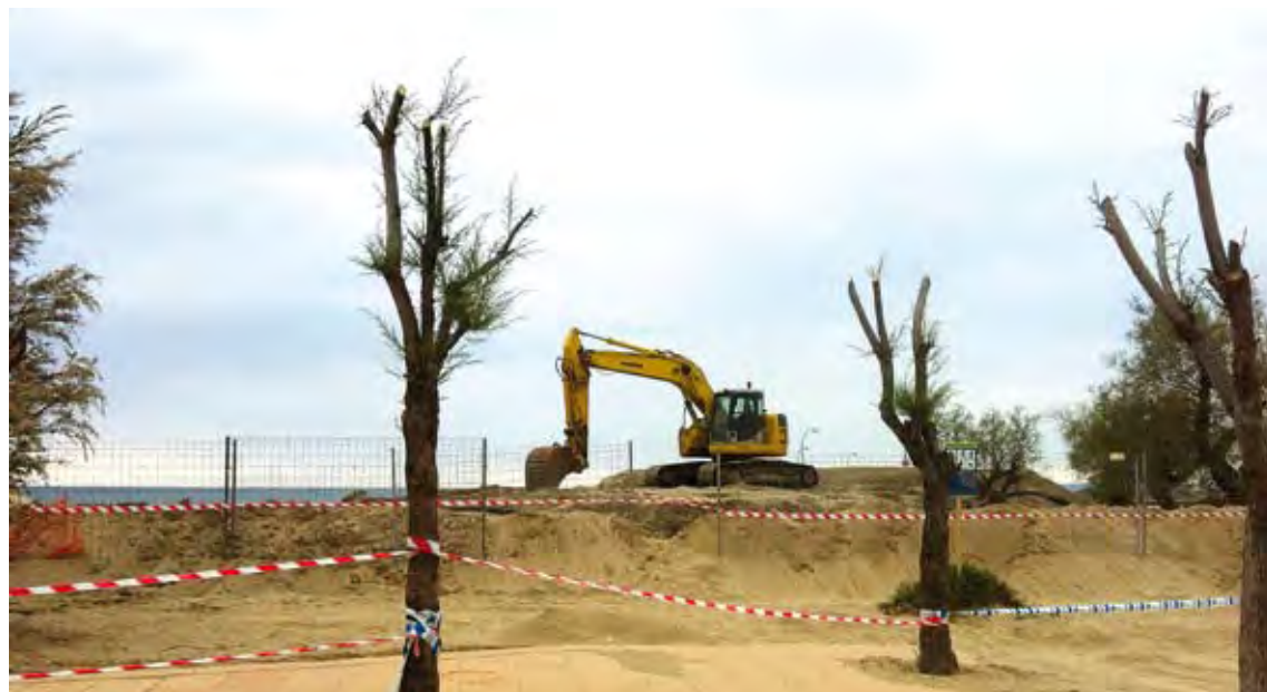
4.000 METRES CÚBICS. El material s'ha extret de la sortida dels canals de Santa Margarida G. VISA
