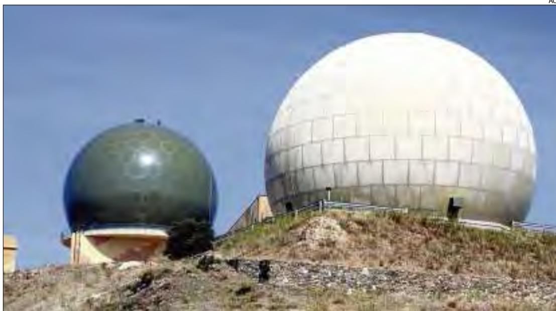
Les dues boles instal·lades de forma provisional a la base aèria del Pení de Roses.
