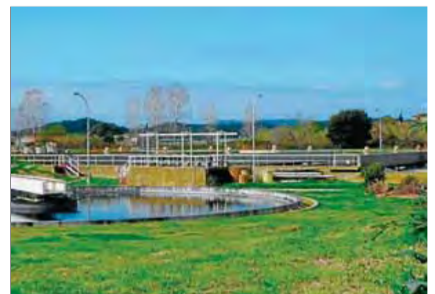
La depuradora de Palamós, que també cobreix Mont-ras, Calonge i Vall-llobrega, inaugurada el 1985 ■ A.V.
