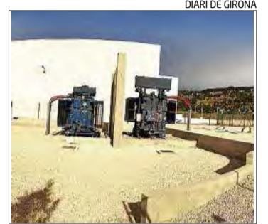
La nova infraestructura.
