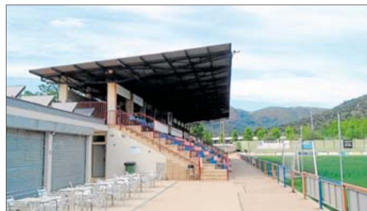
La coberta de l'Estadi Municipal que se substituirà. AJUNTAMENT DE ROSES
