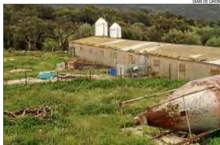
Part de les instal·lacions exteriors de la granja de porcs.
