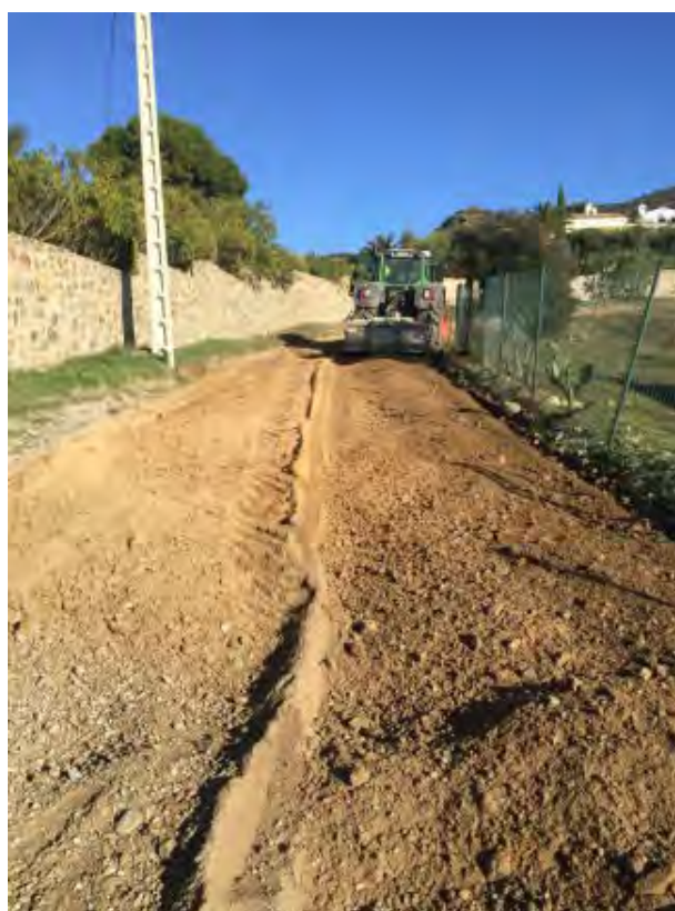
Les obres al camí ja s'estan executant. AJUNTAMENT DE ROSES
