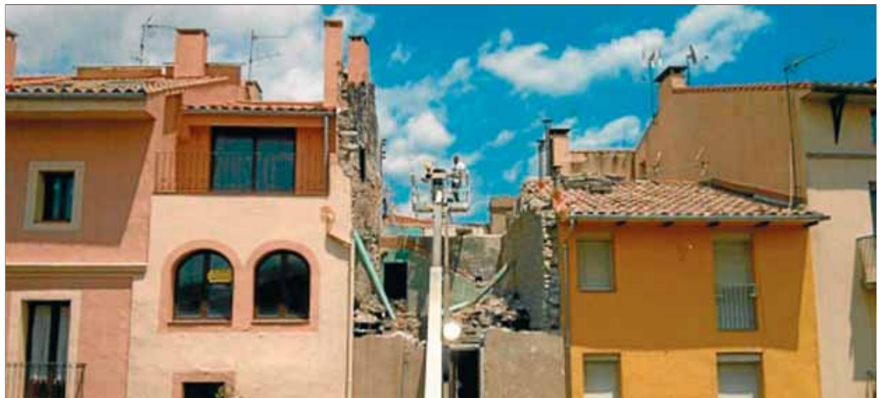
Un detall dels treballs d'enderrocament que s'han dut a terme a l'avinguda del Comte Guifré de Sant Joan ■ J.C.
