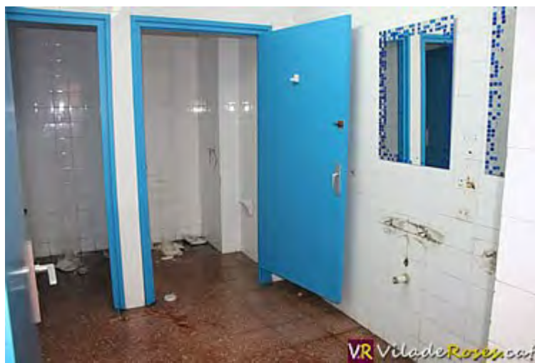
Avui s'han iniciat les obres de renovació dels lavabos del Mercat Municipal de Roses
