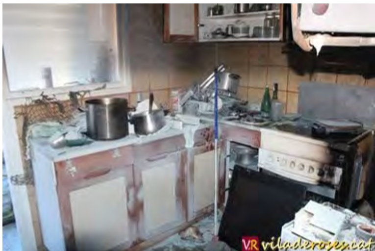
Tota la cuina ha quedat afectada per les flames
