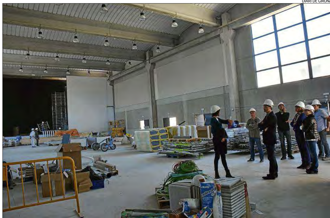
Regidors de l'Ajuntament en una visita a les obres.
