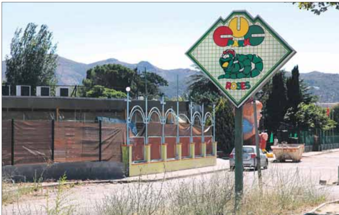
Fa setmanes que les instal·lacions del complex de l'antic Cuc Park està en obres. GERARD BLANCHÉ
