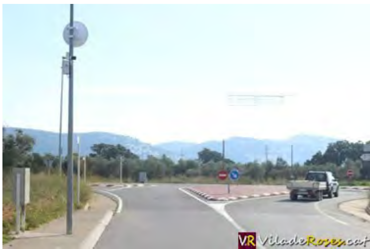
Càmera instal·lada a l'entrada de la urbanització de Mas Boscà
