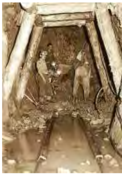
FOTOS PORTADA: UNS OBRERS TREBALLANT EN UN DELS TÚNELS PER AL PAS DE LA CANONADA DEL TRANSVASAMENT D'AIGUA DEL TER A BARCELONA. (FOTO: ARXIU ACA).
