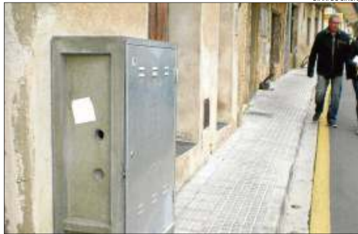
Caixes col·locades a les voreres que impedeixen el pas.
