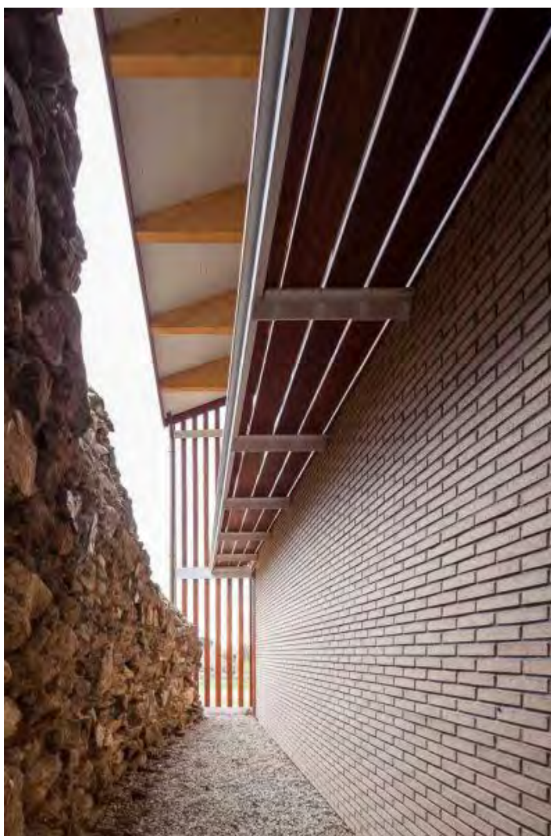
Muro existente y bóveda reconstruida, Ciutadella de Roses . Arq.: Joan Falgueras. Imagen: Marc Torra
