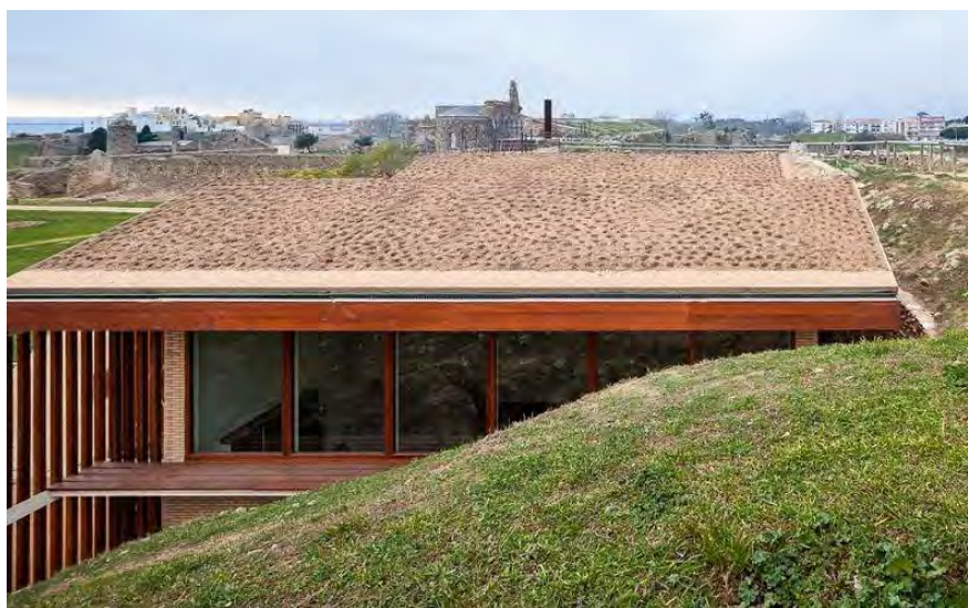
Cubierta de las casamatas, Ciutadella de Roses . Arq.: Joan Falgueras. Imagen: Marc Torra
