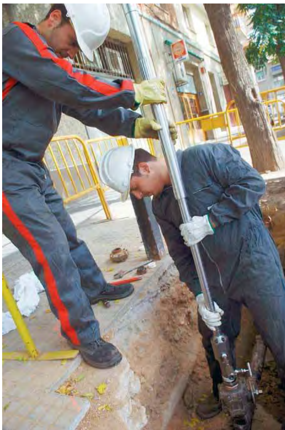
Uns operaris de Gas Natural fan tasques de reparació a la xarxa de gas ■ ACN / GAS NATURAL
