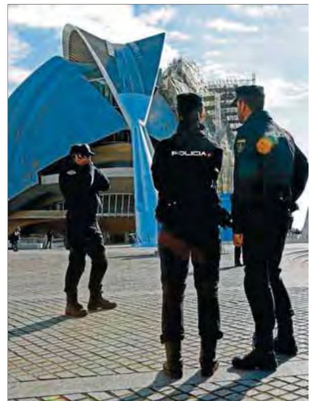
Tres policies en les proximitats del Palau, que està sent reparat per la caiguda del trencadís ■ JOSÉ CUÉLLAR
