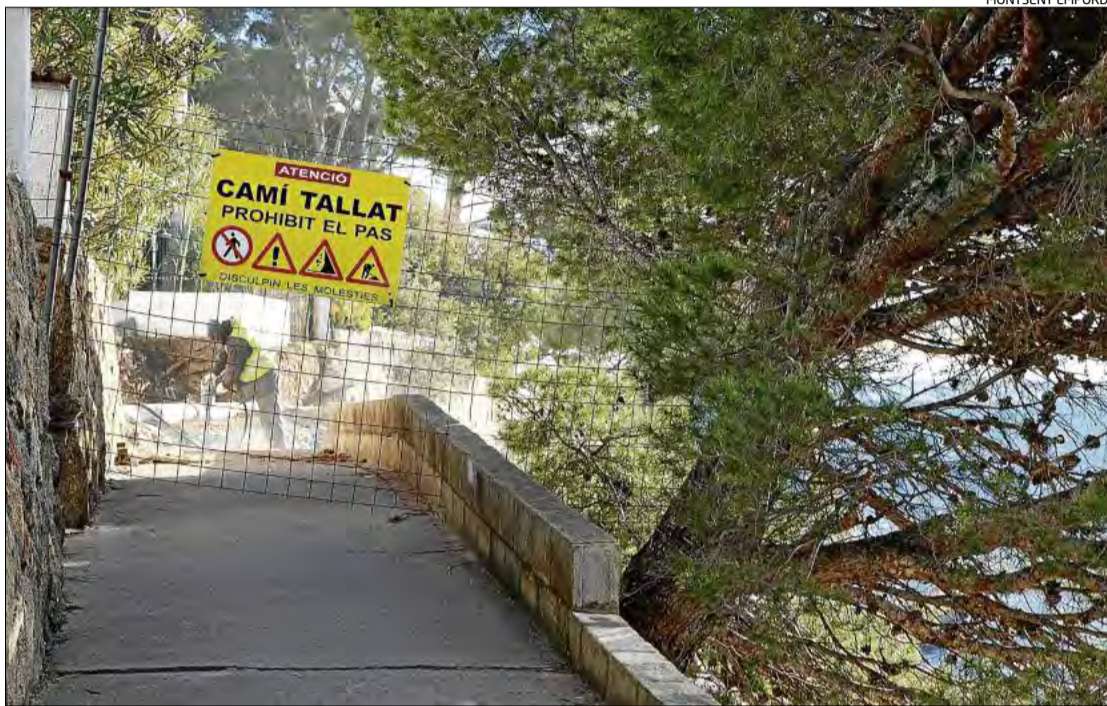
Els operaris treballant en la demolició manual de la passera d'obra del camí de ronda.
