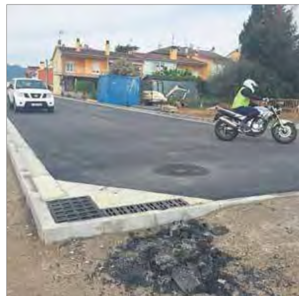
Dos vehicles passant ahir pel nou tram del carrer de Baix. Queda pendent de fer la vorera ■ J.N.
