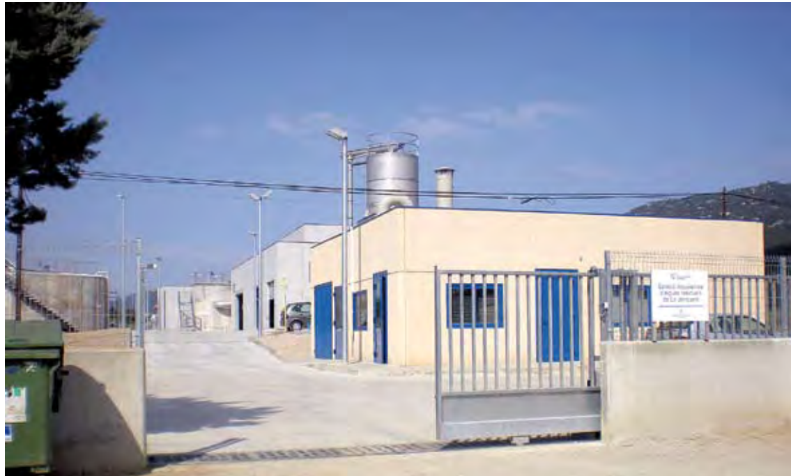
DEPURADORA DE LA JONQUERA. Les instal·lacions es van ampliar fa cinc anys
