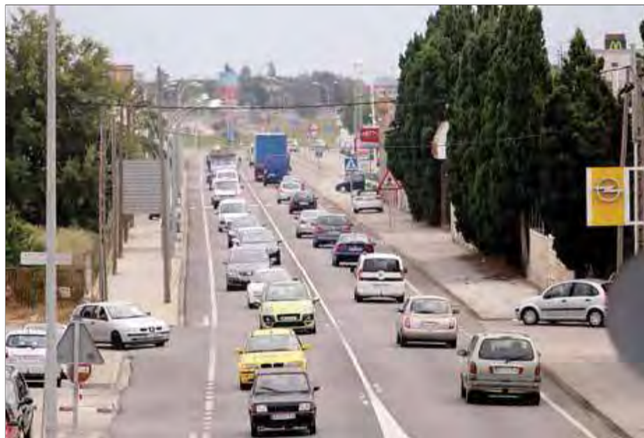
El tram de la C-260 que serà desdoblada, en una imatge d'ahir ■ MANEL LLADÓ
