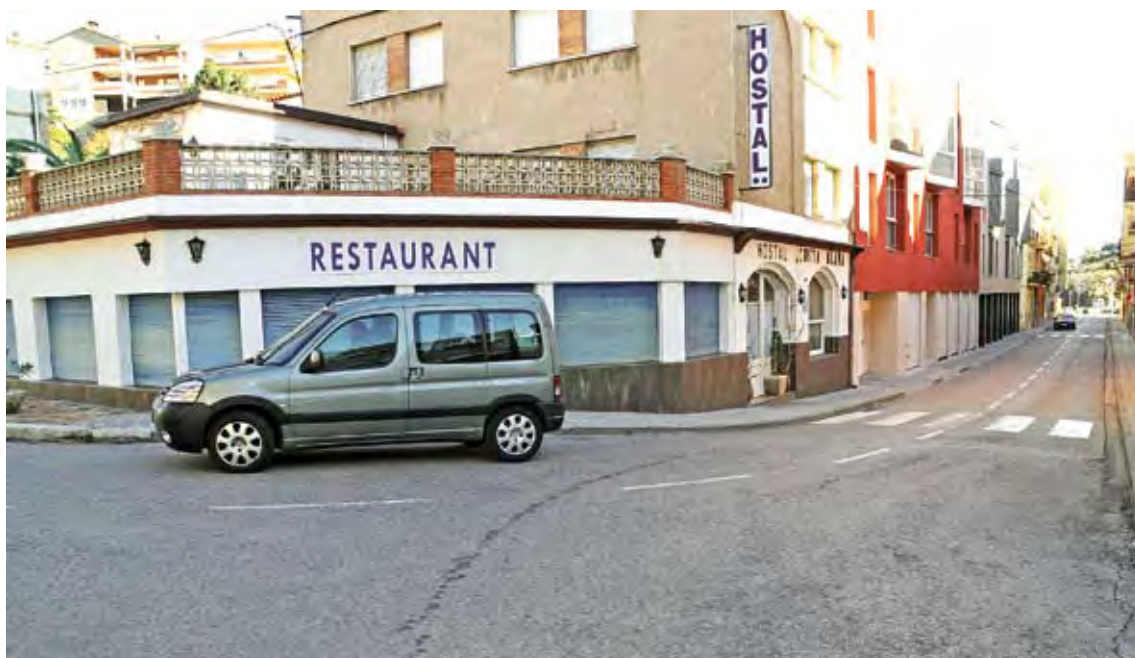
N-260 A PORTBOU. Una via pendent d'arranjaments i amb efectes colaterals dins el nucli urbà
