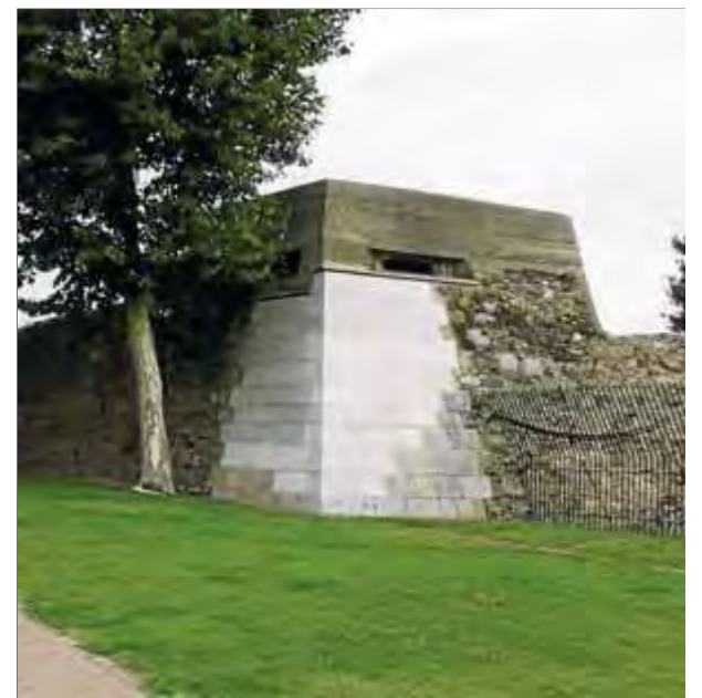
Un dels angles de la ciutadella on s'ha actuat per recuperar els carreus que havien desaparegut ■ EL PUNT AVUI
