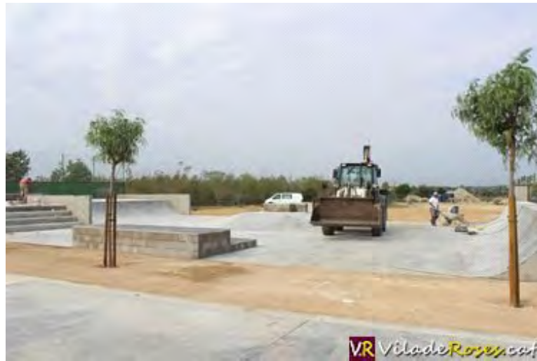
Operaris enllestint les obres del skate parc de Roses aquesta setmana
