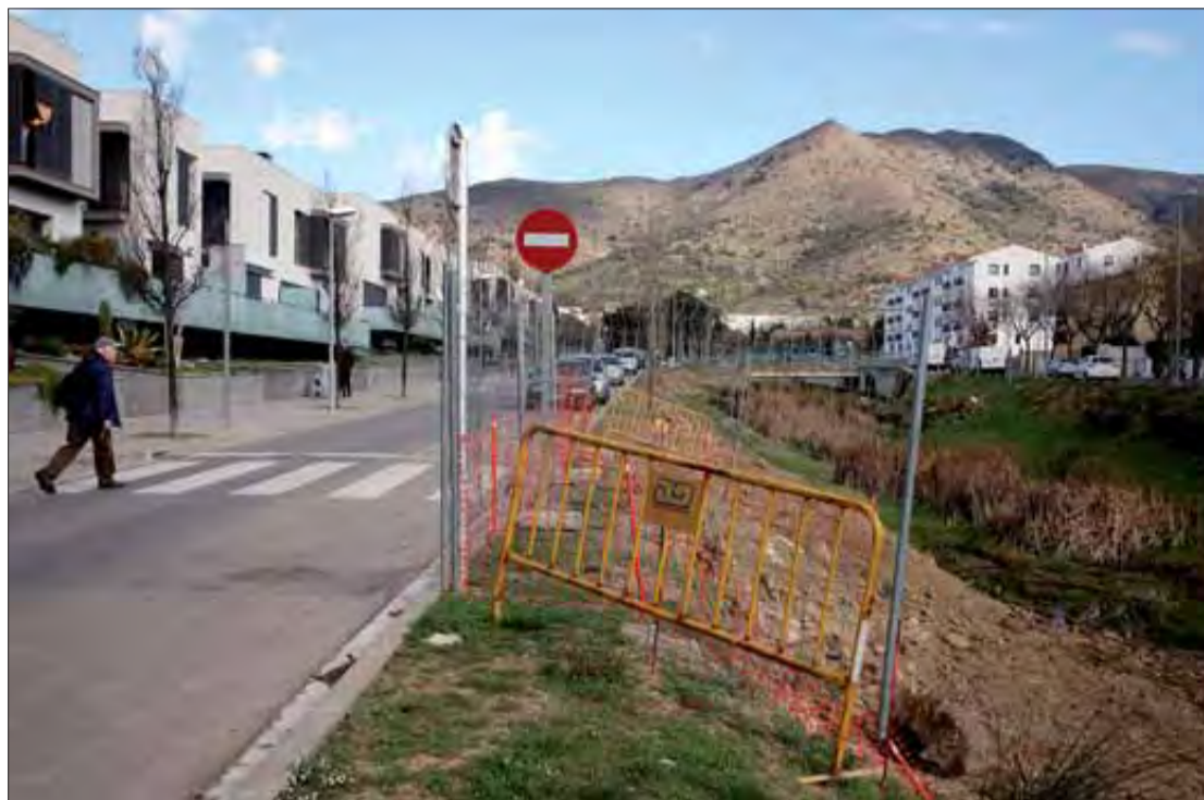
Els veïns que freqüenten la zona aplaudeixen que s'hagi començat a construir la passera. MONTSENY EMPORDÀ
