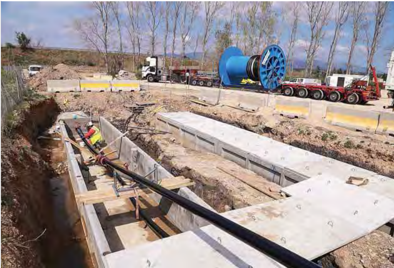
Vista de la cambra d'empalmament de cables en què treballaven ahir prop de Vilarnadal. A la dreta, els operaris desenrotllant el cable de la bobina i estirant-lo des de l'altra punta ■ M. LLADÓ
