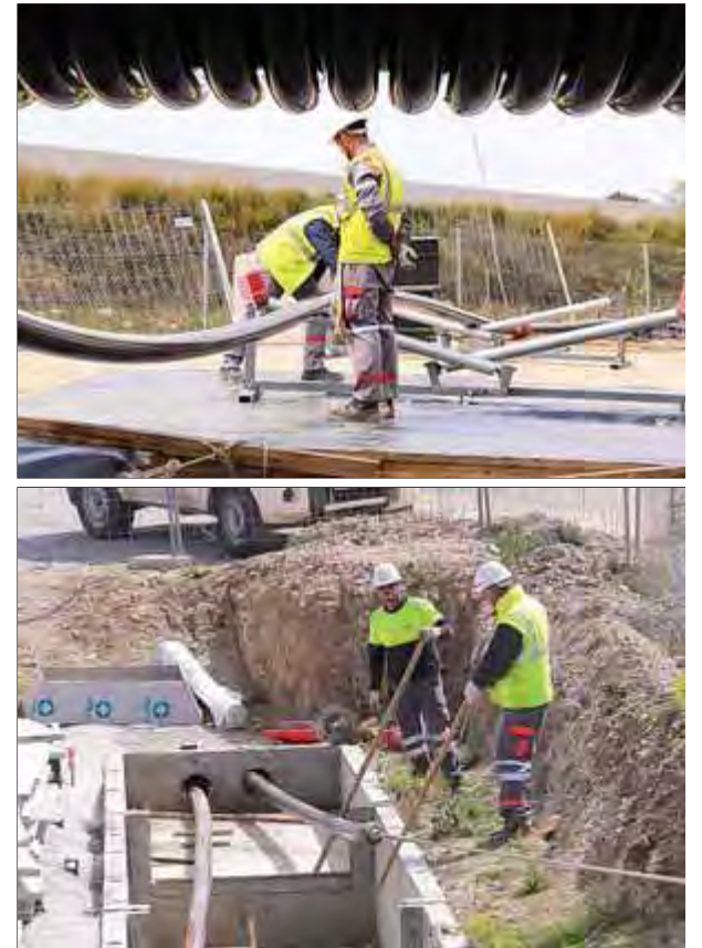
Vista de la cambra d'empalmament de cables en què treballaven ahir prop de Vilarnadal. A la dreta, els operaris desenrotllant el cable de la bobina i estirant-lo des de l'altra punta ■ M. LLADÓ
