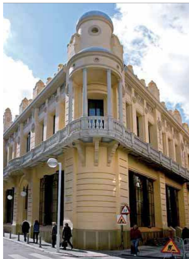
L'edifici del Casino Menestral, en què es va reformar la façana però falta arreglar l'interior ■ LLUÍS SERRAT
