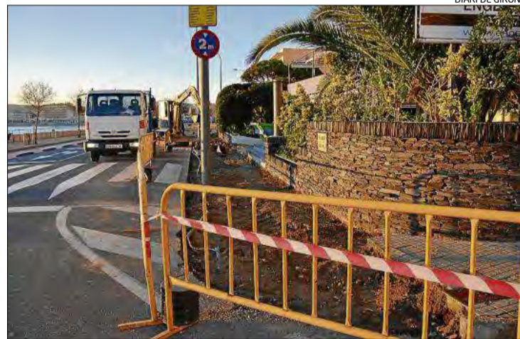
Un tram de vorera que ja s'ha aixecat.
